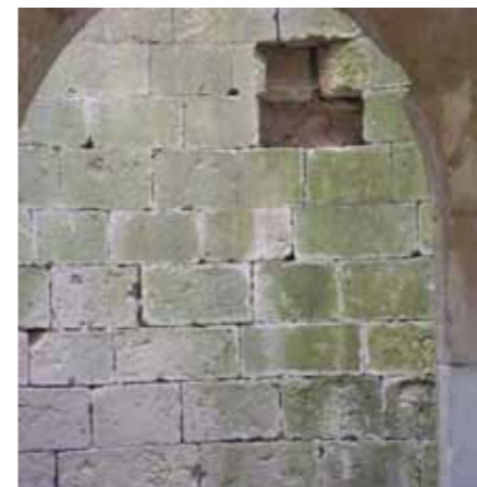
Scorcio dell'ambiente interno della torre mastra, con graffiti dei galeotti
